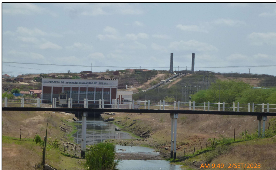
RH5 – BH Médio Jaguaribe – Casa de Bombas do Canal do Trabalhador
