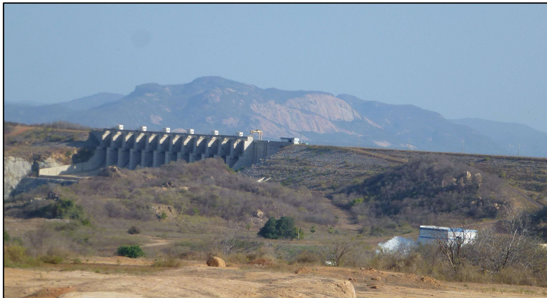
RH5 – BH Médio Jaguaribe – Barragem de Castanhão
