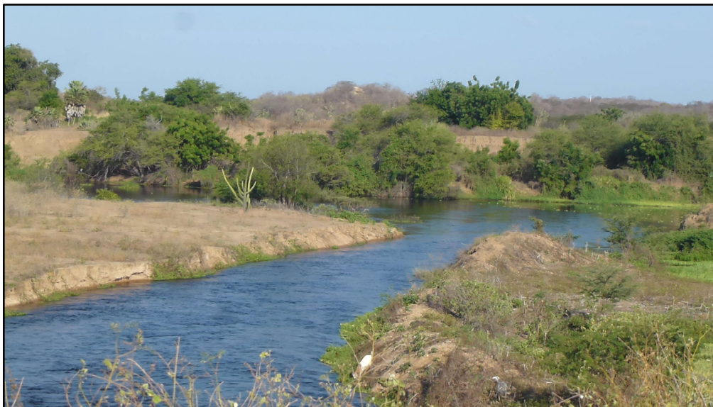
RH5 – BH Médio Jaguaribe – Canal de Fuga da Casa de Força de Castanhão
