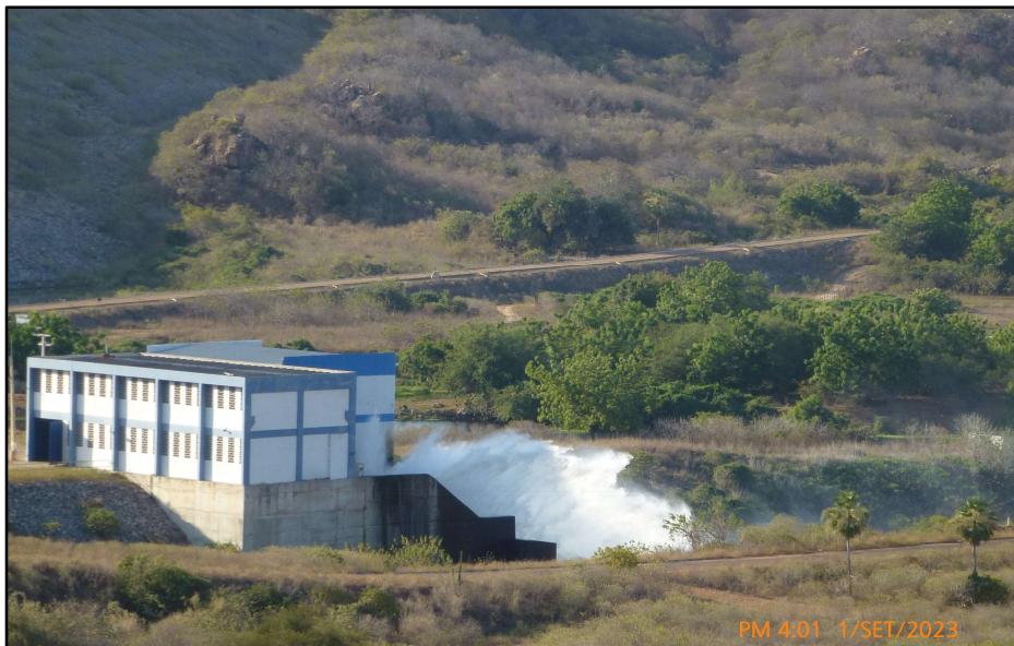
RH5 – BH Médio Jaguaribe – Casa de Força e Descarregador de Fundo de Castanhão
